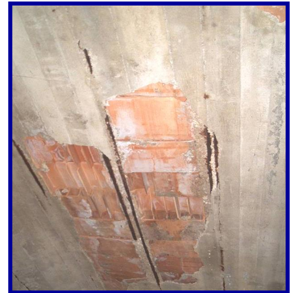
Corrosione armature travetti
