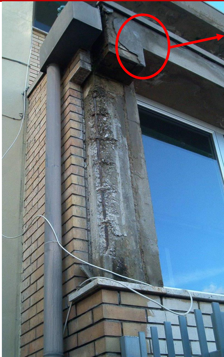
Corrosione armature travetti
